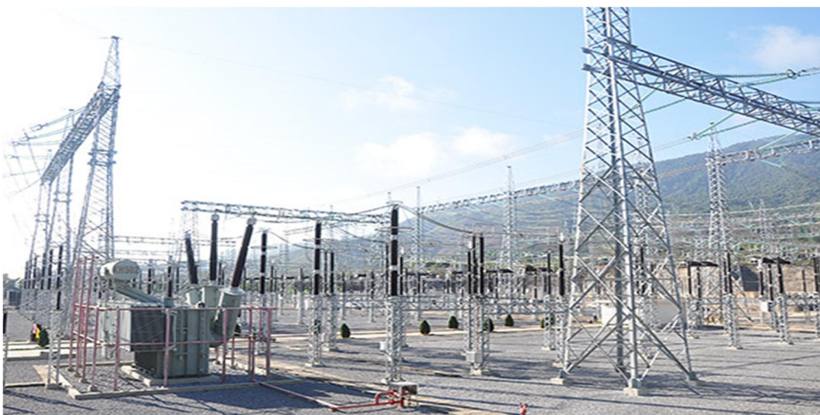
Trạm biến áp 500kV Sơn La
