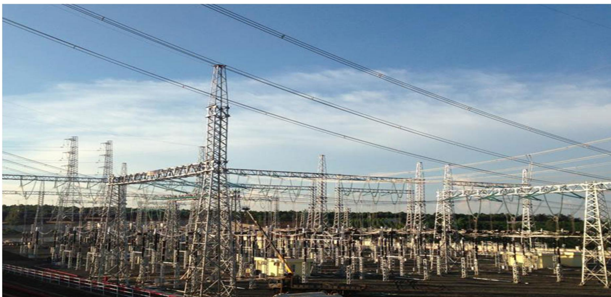
Trạm biến áp 500kV Pleiku
