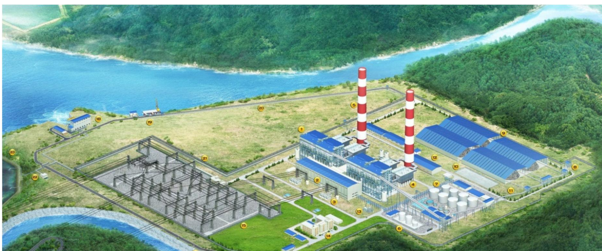
Nhà máy nhiệt điện Mông Dương 1
