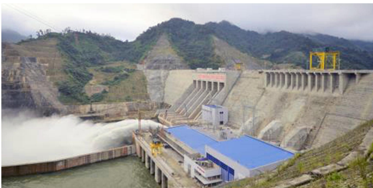
Thủy điện Lai Châu (khánh thành ngày 20/12/2016)
