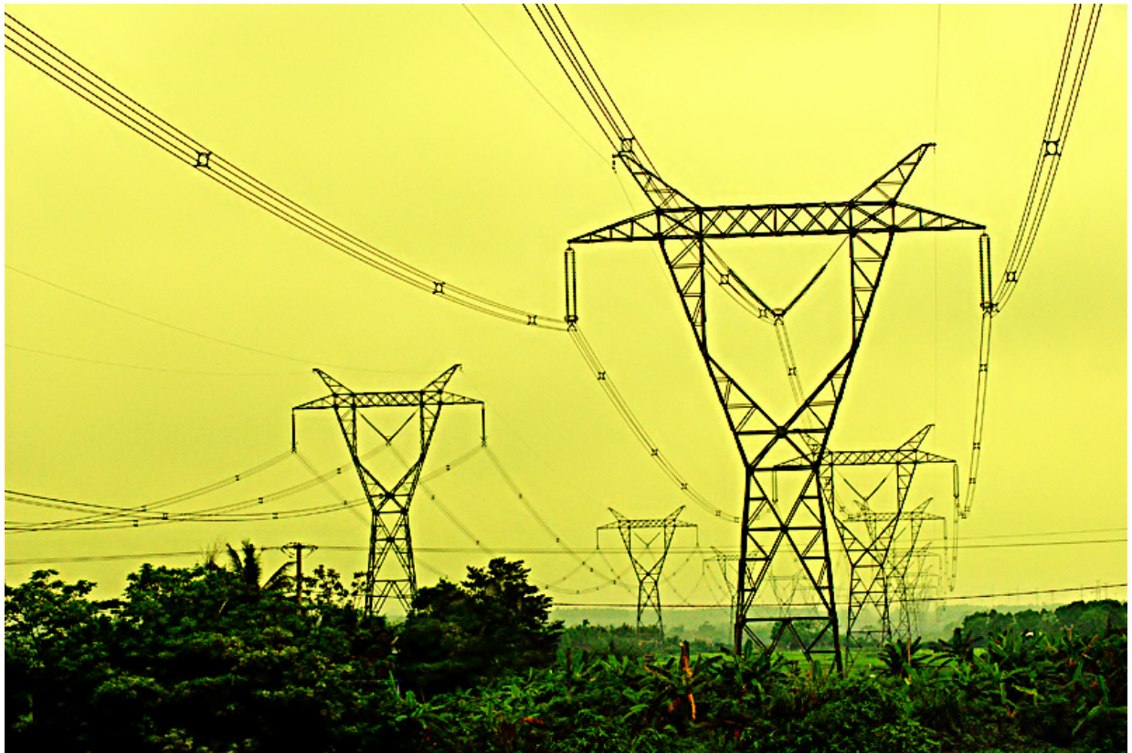
Đường dây 500kV Bắc - Nam (mạch 1)
